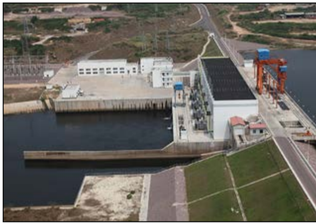
Barrage hydroélectrique d'Imboulou, le développement passe par la maîtrise de l'énergie.
