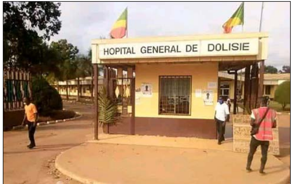
Hôpital de Dolisie.
