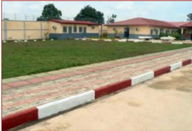
Les anciens bâtiments réhabilités
