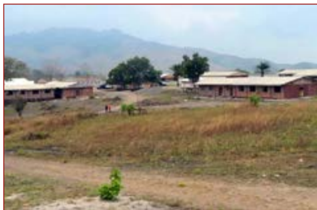
Le site d'Aubeville en construction
