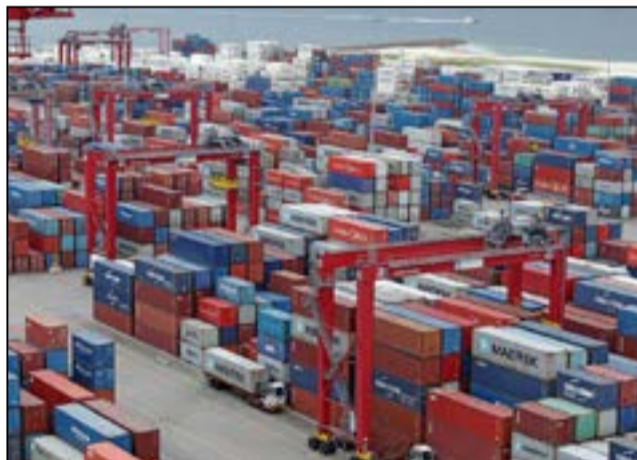
Le trafic des conteneurs est important au Port autonome de Pointe-Noire
