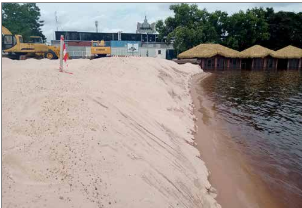
A gauche le ban de sable de la plateforme qui dépasse le niveau des eaux du fleuve en crue
