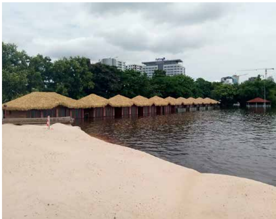
A gauche, le ban de sable de la plateforme, à côté des maisons en bois inondées par le fleuve
