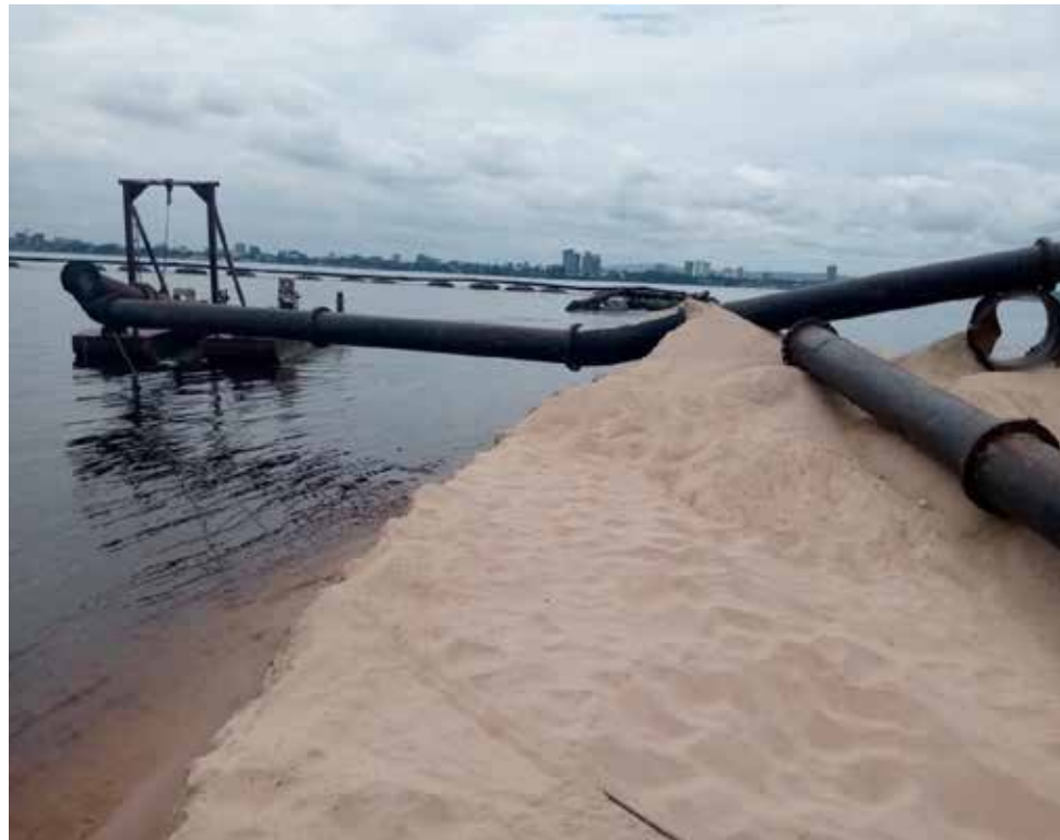
Les travaux de remblayage de la plateforme sur le Fleuve Congo
