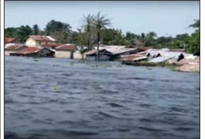
La localité de Mossaka est entièrement dans l'eau.
