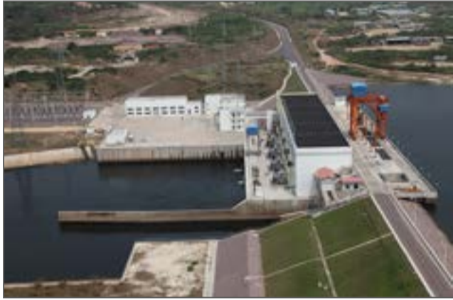
Barrage hydroélectrique d'Imboulou, le développement passe par la maîtrise de l'énergie..
